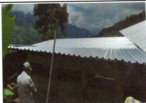
Foto 5: Entechado de baños
