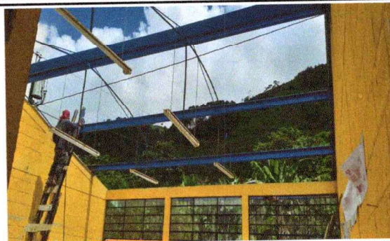
Foto 2: mantenimiento estructura del lado interno.
