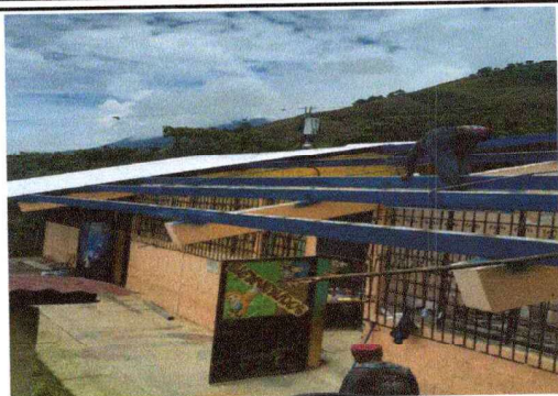
Foto1: Desinstalacion de estructura de lámina en aulas y direccion.
